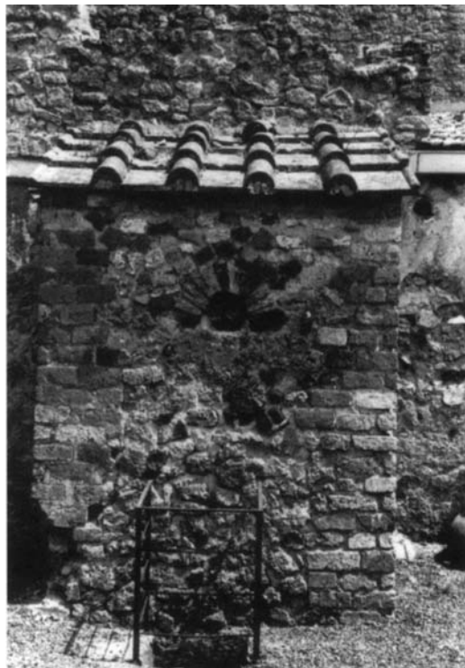
Afb. 8. Opening van de beerput in de tuin achter het toilet in het huis van de Zilveren Bruiloft. Let op het kleine toiletraampje.
