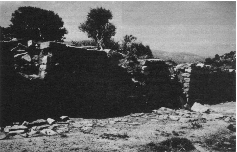
Afb. 1: Zóminthos, gedeelte van de ca. 60 m. lange muur van het groot Laat-Minoïsch paleisachtig gebouw. In de op verscheidene plaatsen tot meer dan twee meter hoog bewaard gebleven muur zijn nog twee ramen en een deur te zien. (Foto auteur)
